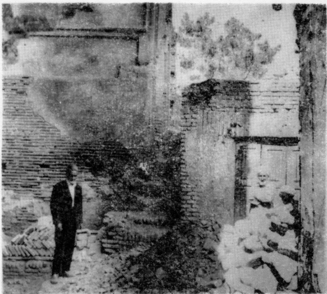
قسمت غربی رواق بزرگ شمالی حوض چارسوق در آغاز ترمیمات شامل پلان سال ۱۳۶۱ .
